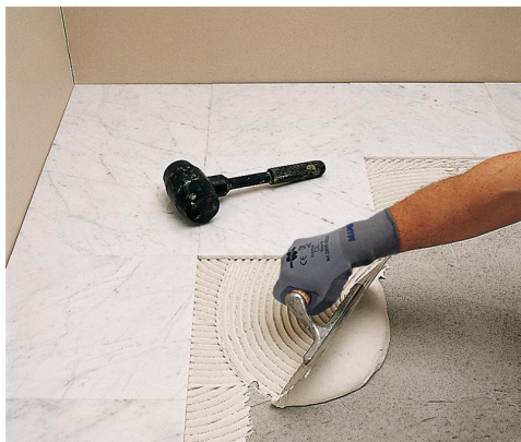
Collocación de mármol blanco de Carrara con Keraquick S1 blanco
