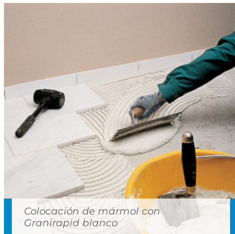
Instalación de fijación de cemento de caucho con Granirapid.
