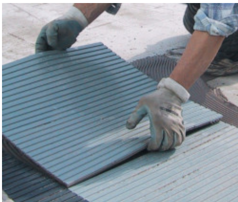
Instalación de fijación de cemento de caucho con Granirapid.
