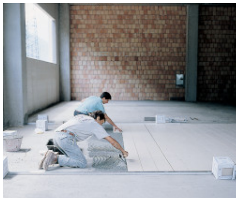
Instalación de porcelanato en un entorno industrial
