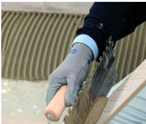
Doble extensión del adhesivo según norma UNI 11493
