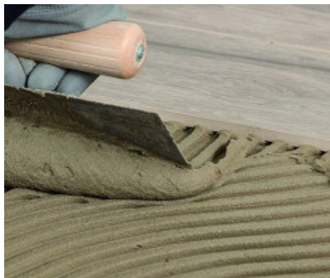
Instalación de porcelanato "imitación madera" en el suelo
