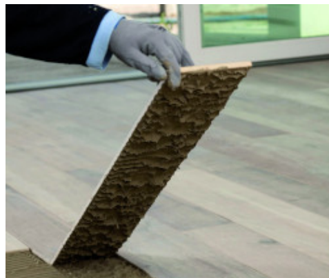
Excelente humectación del reverso de la placa.
