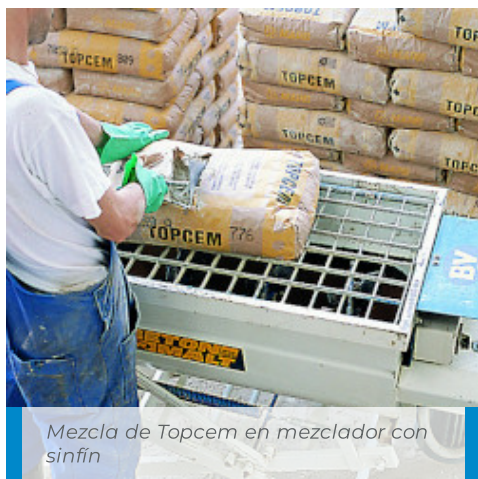
Mezcla de Topcem con sistema automático de bombeo
