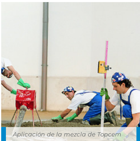
Mezcla de Topcem con sistema automático de bombeo
