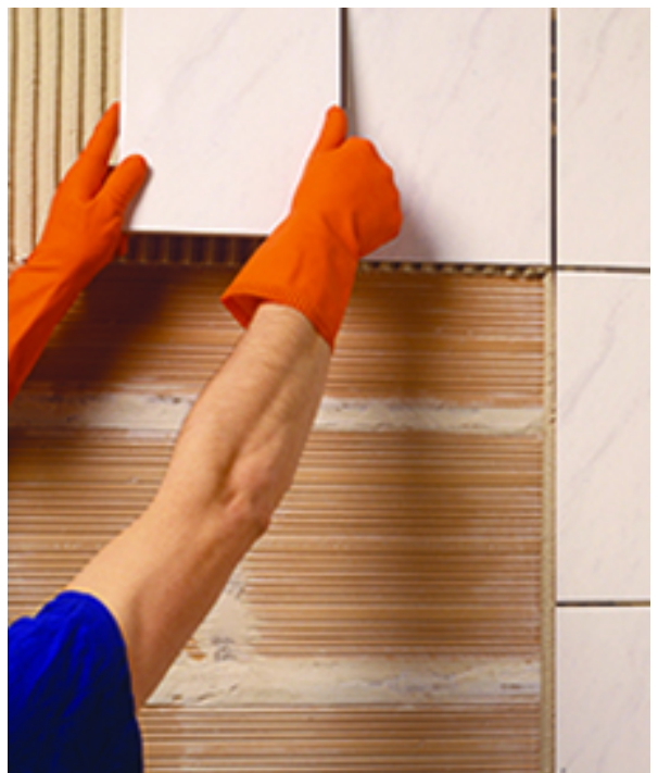
Colocación en pared de revestimiento cerámico
