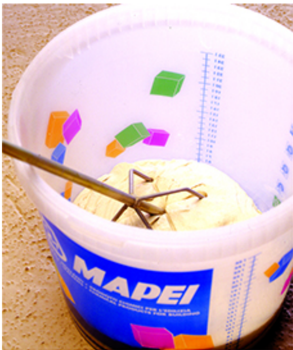
Mezcla de Mapeket con agitador mecánico
