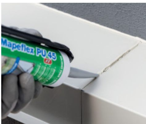
Sellado elástico de juntas de construcción
