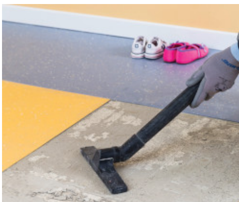
Eliminar el polvo con una aspiradora
