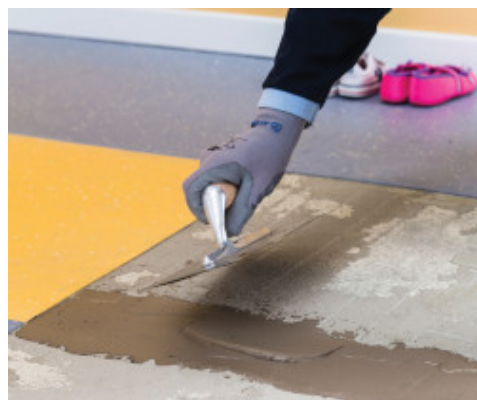
Regularizando una porción de la superficie
