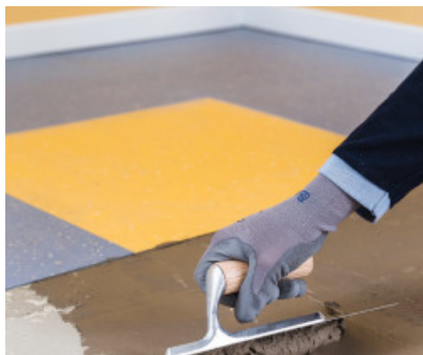
Regularizando la superficie a un borde de pluma
