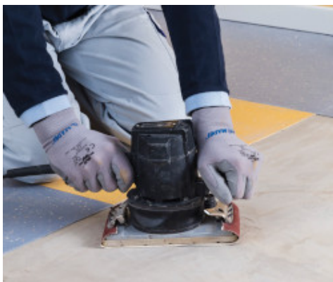
Lijando la superficie después de 2 horas
